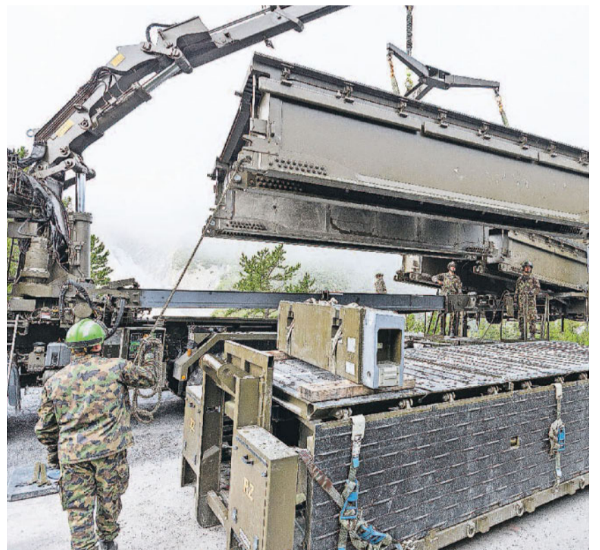
Armee. Brückenelemente werden durch eine Armeeinheit über einen Murgang im Val S-charl eingeschoben.
