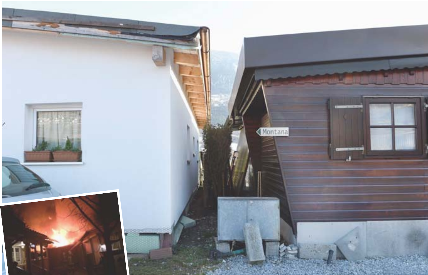
L'incendie qui s'est déclaré le 28 mars dans le camping du Mazot à Salquenen aurait pu également avoir lieu dans d'autres campings, comme celui du Robinson, où les normes antifeu ne sont pas respectées. SABINE PAPILLOU
